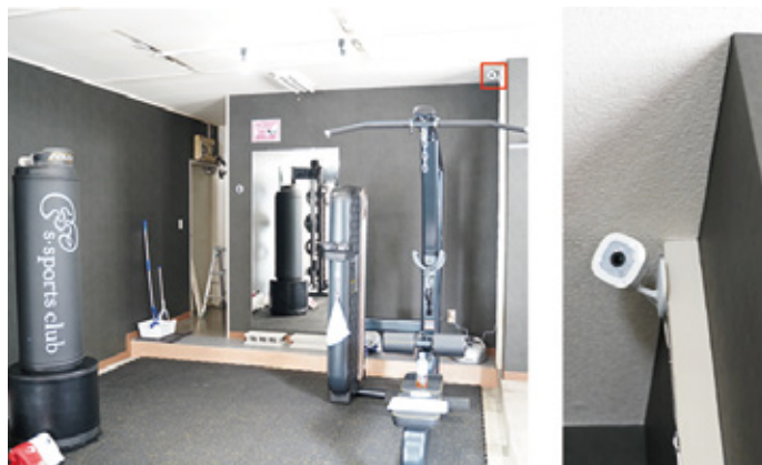
ジム内に設置された Arlo Q。入退出管理、危険防止、防犯のために利用されている。
