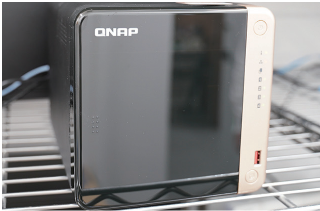
オフィスに設置されたQNAP製NASのTS-464-8G
